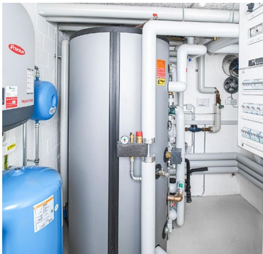
Oben: Komplexes System, einfache Umsetzung: Wechselrichter und Ausgleichgefäss (links), Kombispeicher (Mitte) und rechts das Tableau mit dem Solarmanager Smartfox Pro.
